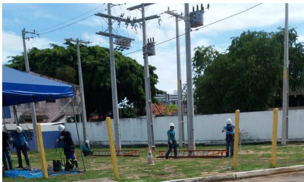
Figura 2: Preparação para a realização do treinamento na arena.
