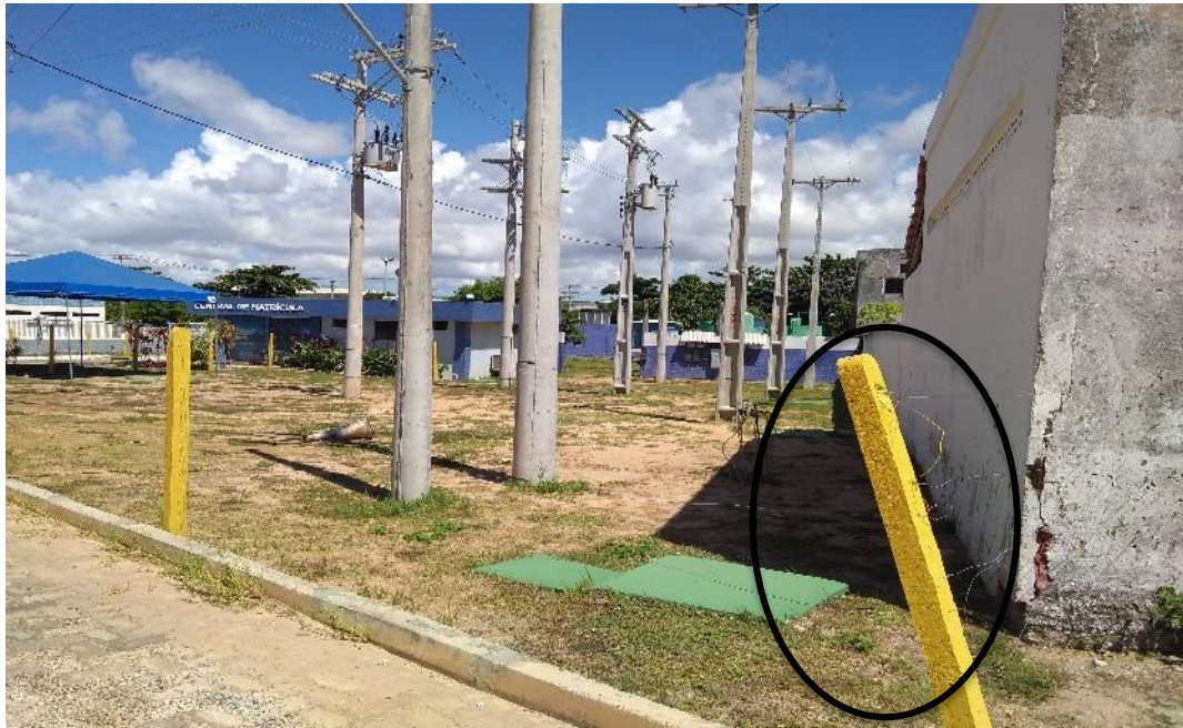
Figura 10: Estaca inclinada com possibilidades de queda.
