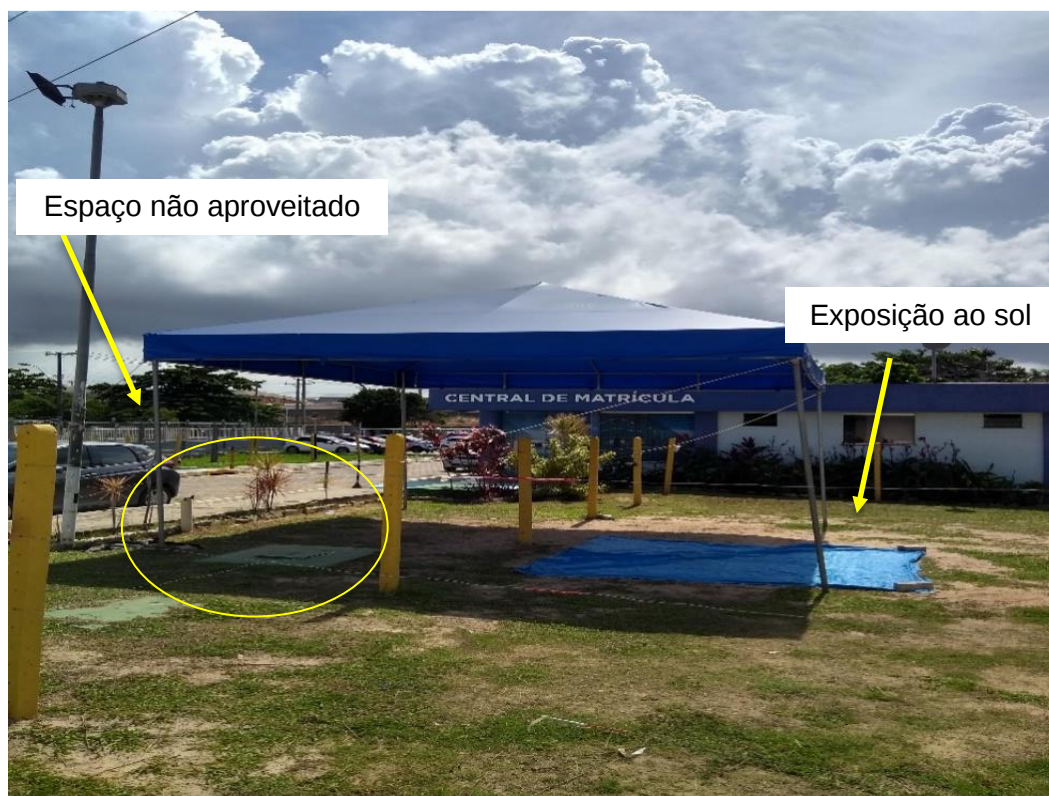
Figura 7: Dimensionamento e posicionamento irregular do toldo.
